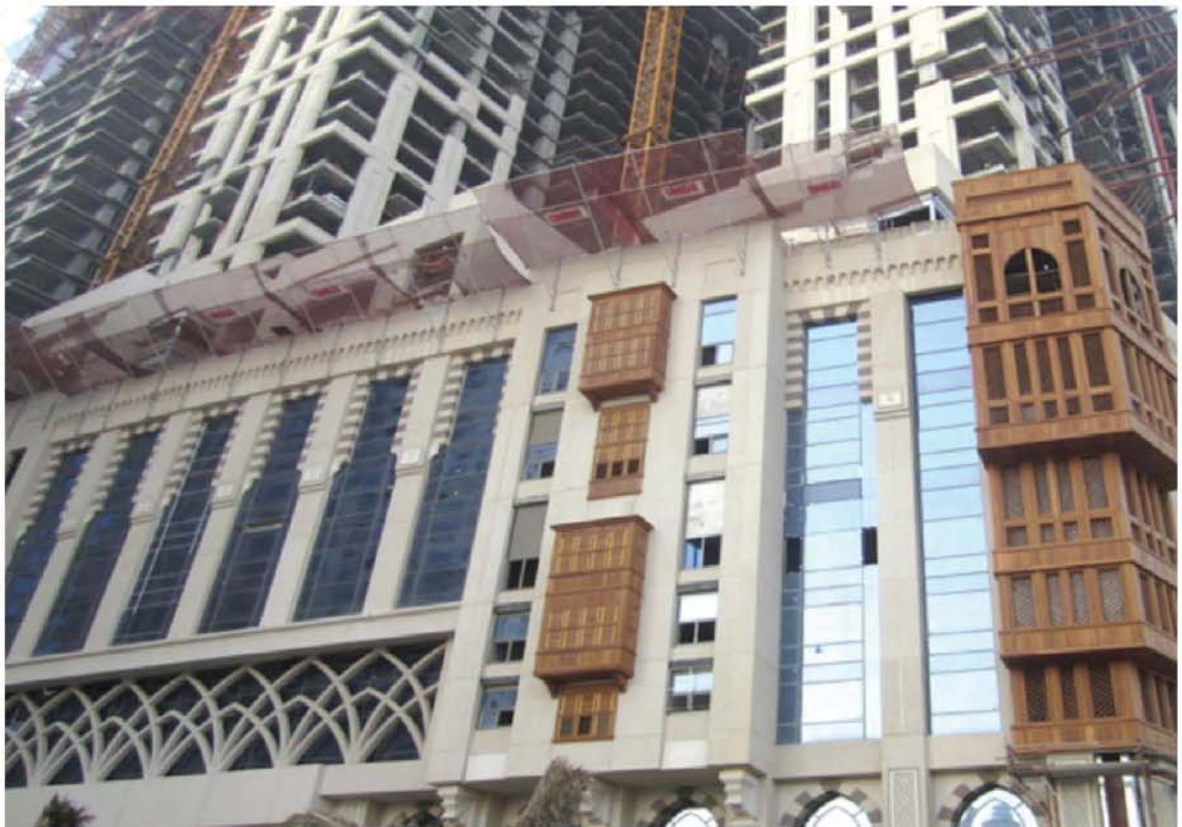
الأعمال الحالية بمنطقة S1
