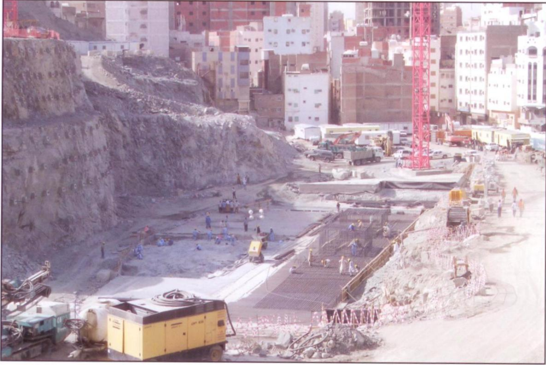
أعمال الأساسات للأبراج (PR1A _ PR1B _ PR1C) من جهة دحلة الرشد
