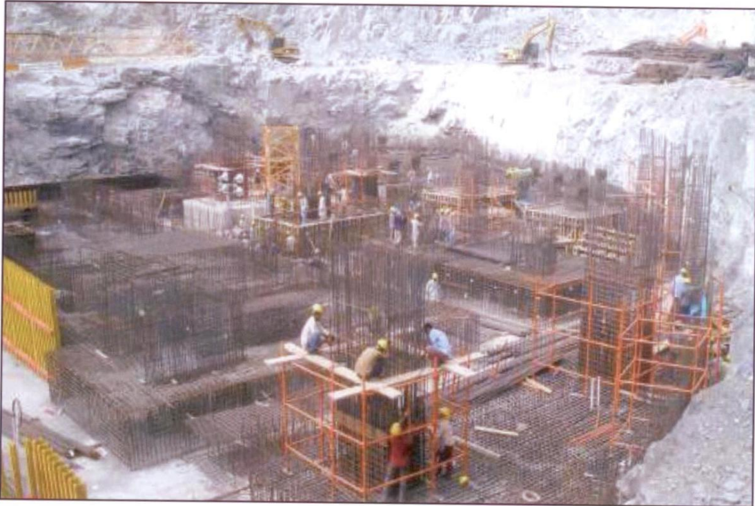
أعمال الأساسات (للبرج SR7A)
