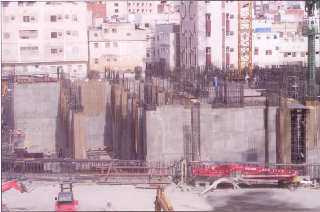
أعمال الخرسانة لخزان المياه الرئيسي بالمشروع
