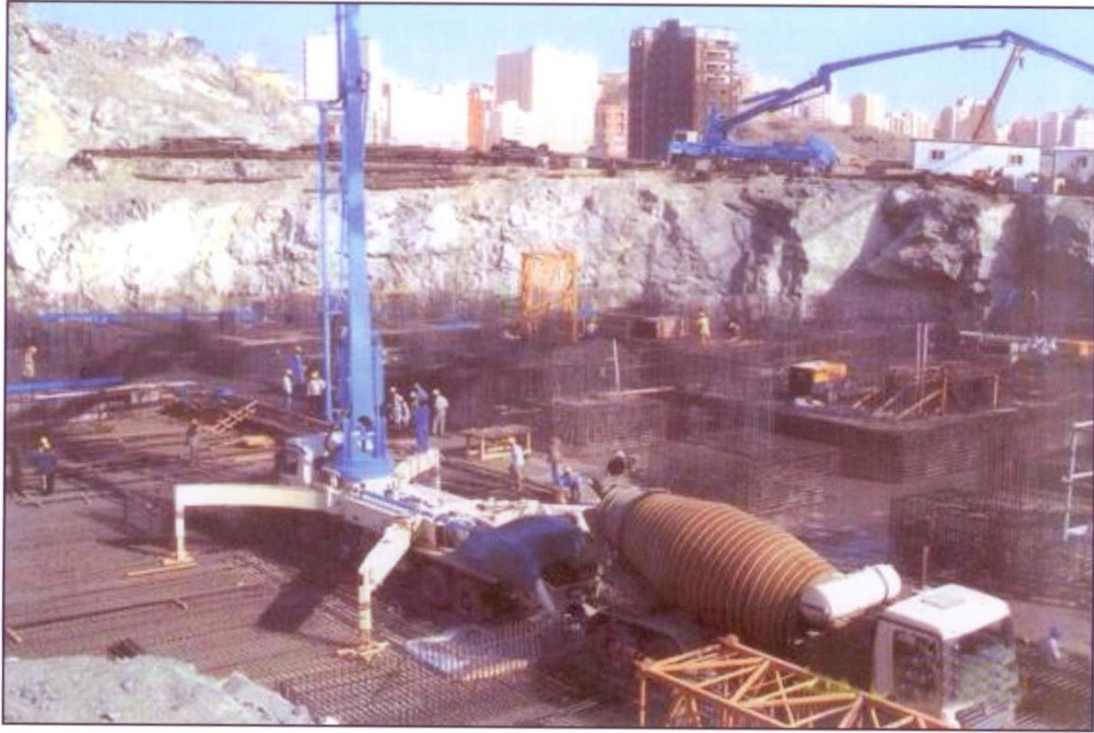
أعمال الأساسات للبرج SR2 بوسط المشروع
