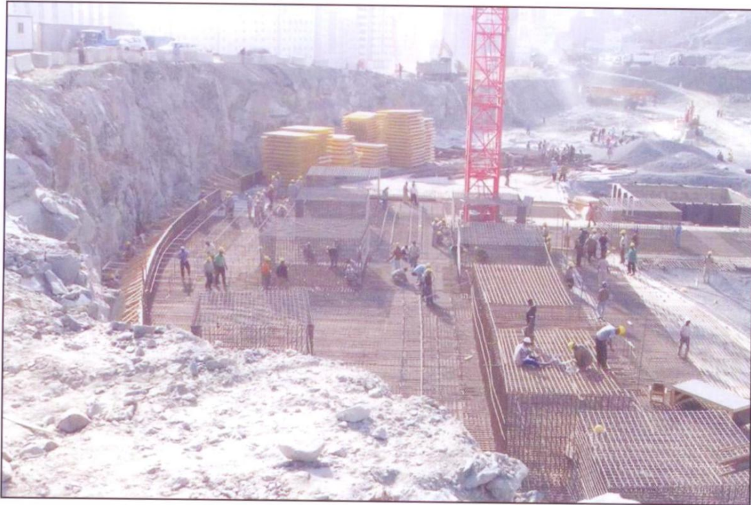
أعمال الأساسات للأبراج ( SR7A - SR7B - SR3 ) بالمنطقة الواقعة بوسط المشروع
