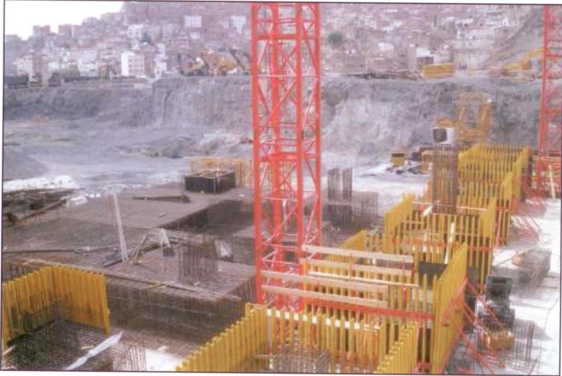
أعمال الأساسات بوسط المشروع (الأبراج SR3 - SR7A - SR7B)
