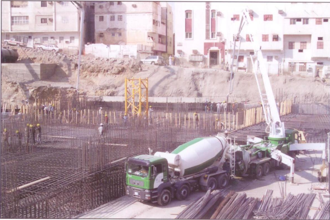
أعمال صب الخرسانة بالمنطقة الشمالية من المشروع
