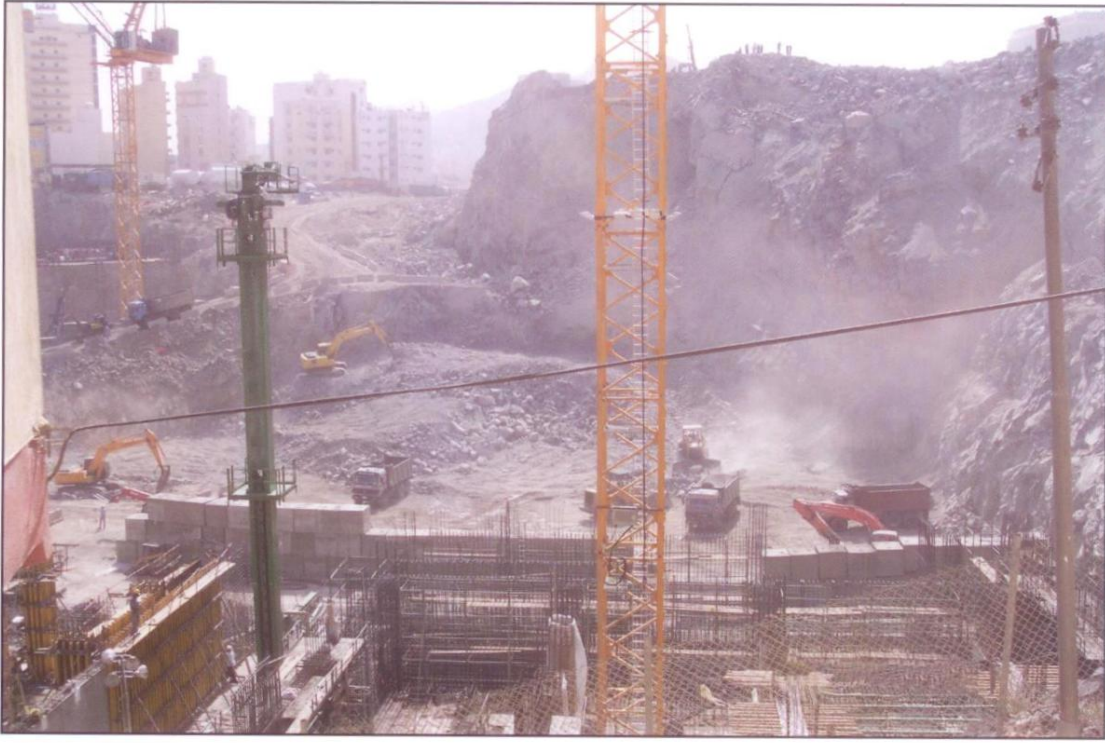
أعمال التفجير و الترحيل في إمتداد المنطقة N1 وتسليح أساسات البرج – H1B
